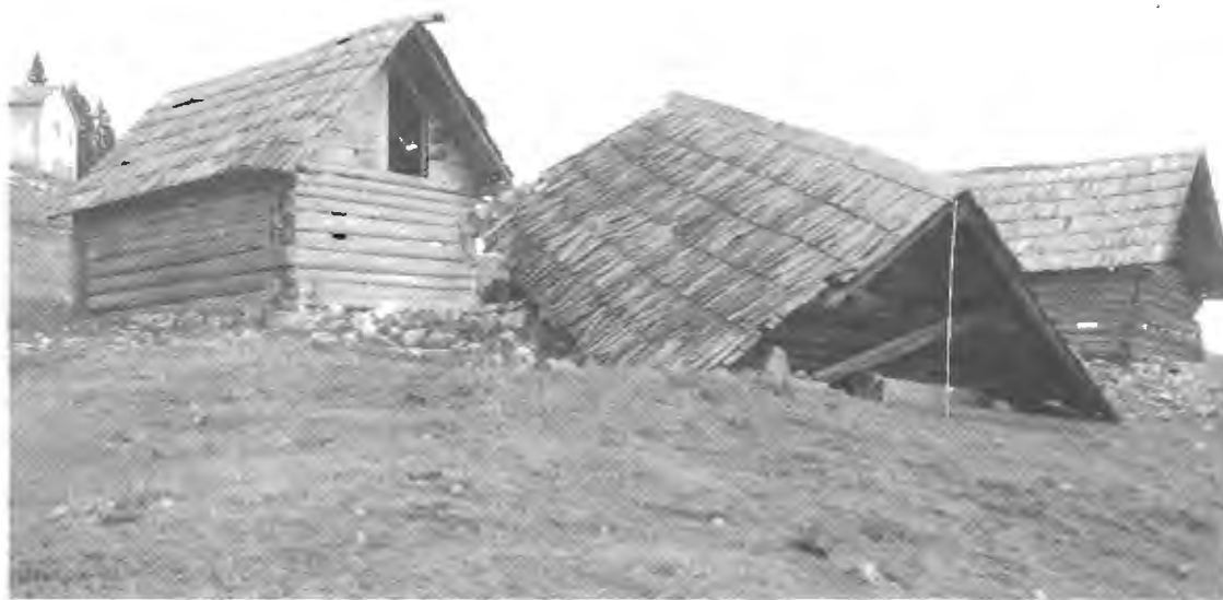
Fig. 8 - Una foto della malga di Campo Manderiolo (Altopiano di Asiago). La parte denominata Campo Manderiolo 1 Nord è l'edificio ancora stante, sulla sinistra. Si notino i tetti ricoperti di scandole e il crollo della porzione C.M. 1 Sud all'esterno dell'area su cui insisteva la struttura stante, dovuto al cassone rigido del Blockbau (Foto Migliavacca & Vanzetti, 1988).
