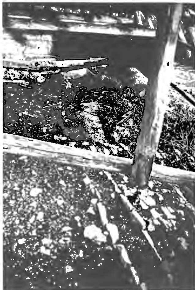
Fig. 69 - L'interno di un porcile abbandonato a Laste Manazzo (Altopiano d'Asiago): si noti la pavimentazione in ciottoli e il canale di scolo centrale (foto: Migliavacca e Vanzetti, 1988).
